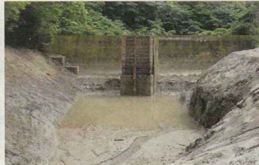
(D 調整池) 容量確保・排水塔の施工管理を指示
